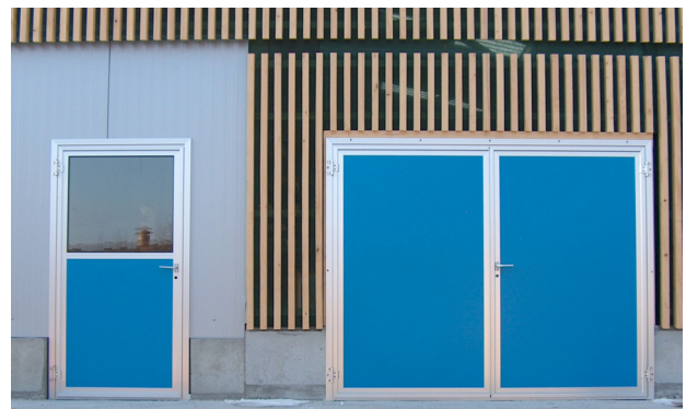
Aluminium - Flügeltor mit isolierter Alustucco - Füllung, pulverbeschichtet nach RAL
