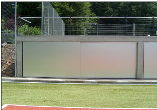
Aluminium - Schiebetore, gegeneinander schiebbar, mit vollflächig geklebtem Alublech, farblos eloxiert
